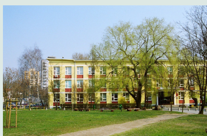
Fot. 2. Budynek przy ulicy Wołyńskiej 35 w Poznaniu. Katedra zajmowała w nim pomieszczenia z lewej strony na piętrach pierwszym i drugim oraz, w podziemiu pokój-chłodnię, pokój kultur tkankowych i pomieszczenia magazynowe (kwiecień 2007 r.).
